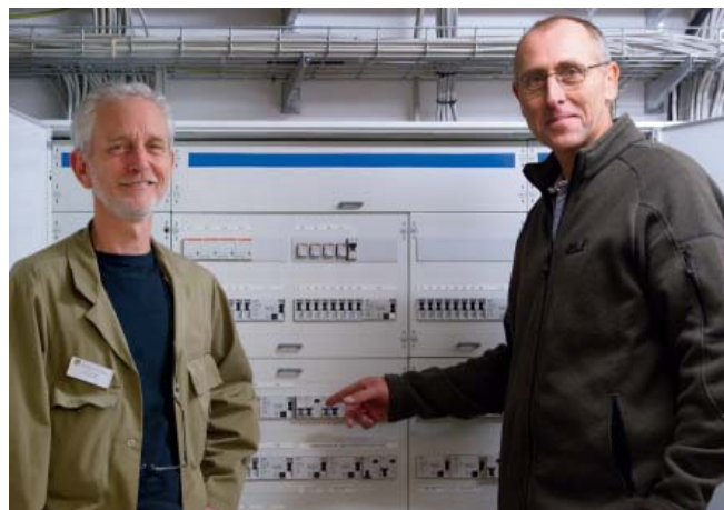
Dziesięć urządzeń AFDD firmy Siemens chroni wrażliwe obwody w szpitalu Karolinen-Hospital Hüten przed powstaniem iskrzenia.
