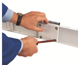
Rysunek 1-7 Wykonywanie bezpiecznego połączenia.
